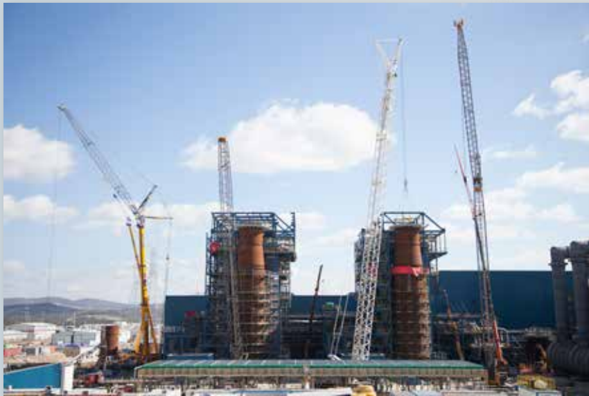
■ HRSG Erection
