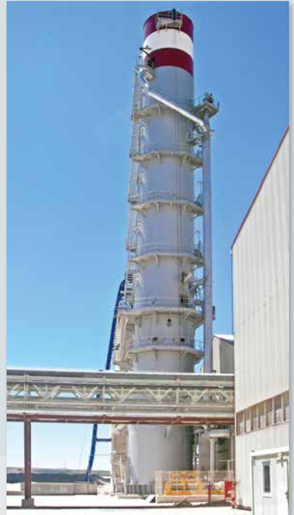
■ Lime Kiln: 500 m 3
